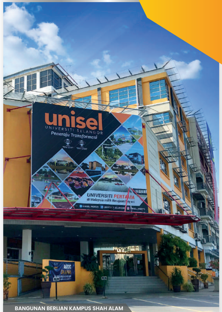
BANGUNAN BERLIAN KAMPUS SHAH ALAM
